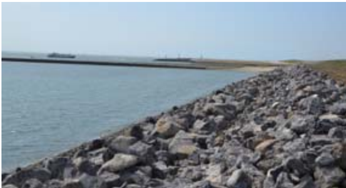
Figuur 5: Voorbeeld van breuksteen op de dijk.
