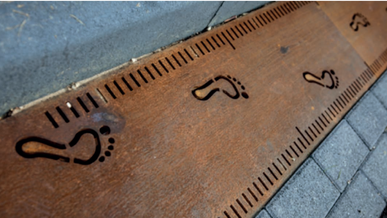
Klimaatgoot in Heerlen (bron: Gemeente Heerlen)
