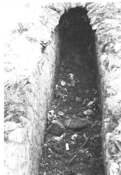
Afb. 20 - Detail van het riool van afb. 19.
