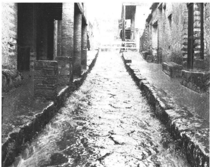
Afb. 18 - Afvoer van regenwater over straat tijdens een bui.
