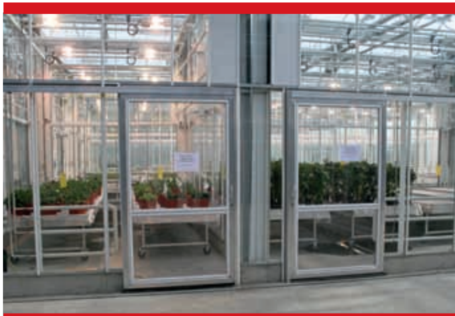
Ook de kleine afdelingen hebben hun eigen specifieke inrichtingseisen; watervoorziening, scherminstallatie, belichting, koeling en luchtbevochtiging.
