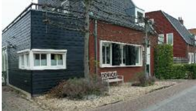
In Papendrecht staan huizen op de dijk op een betonnen plaat met stalen funderingspalen. Bij de volgende dijkversterking worden de huizen opgetild door de buizen te verlengen.
