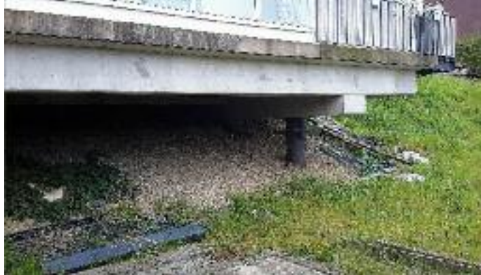
In Papendrecht staan huizen op de dijk op een betonnen plaat met stalen funderingspalen. Bij de volgende dijkversterking worden de huizen opgetild door de buizen te verlengen.
