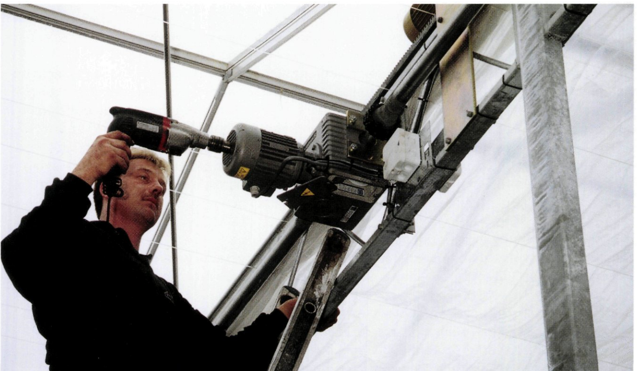
Motorreductor, handmatige bediening bij montage of stroomuitval voor bijstelling (foto PBG/van Vliet Growing Solutions)
