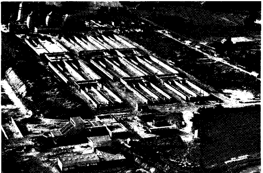
Afb. 5 - Bouw rioolwaterzuiveringsinstallatie te Hengelo. Biologische zuivering in 2 trappen. Eivormige slibgistingstanks. Ontwerp Witteveen en Bos, Deventer. (Foto Aerophoto Teuge).
