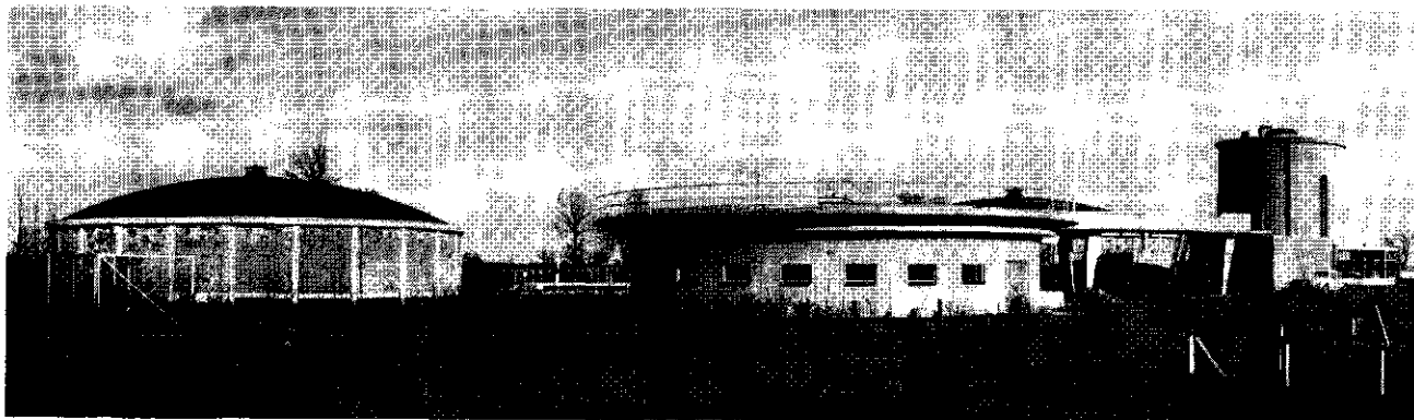
Afb. 3 - Zuiveringsinstallatie te Vriezenveen. Links een overdekt oxydatiebed. In het midden de voorbezinktank en rechts de slibgistingstank.
