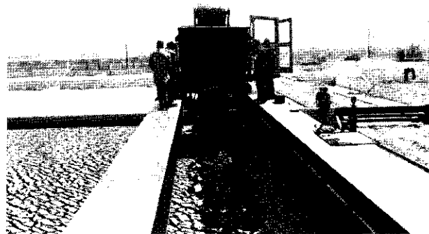
Afb. 16 - Geiger-machine met in het midden het graafgedeelte. Te zien is, dat een gedeelte van het slib is opgenomen.
