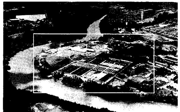
Afb. 18 - ARA Genève (Aire); midden achter dienstgebouw; midden links gebouw voor de slijkbehandeling met verlaadstation voor de filterkoek, rechts daarvan de gistingstanks en indickers; in het midden de aëratietanks met daarboven de voorbezinktanks en daaronder de nabezinkbassins.
