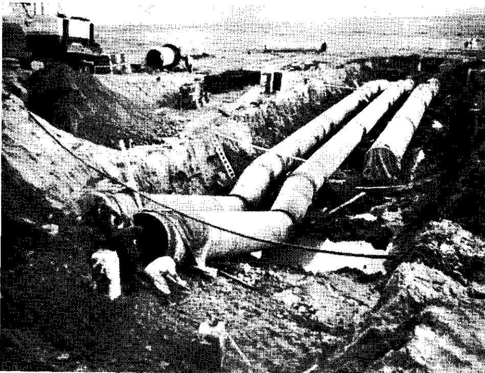
Afb. 7 - Voorzetting van een kruisingsconstructie buiten het dijkprofiel. (De buizen worden op de juiste hoogte gesteld. In de scherpe knikken is een verstijvingsring aangebracht.)
