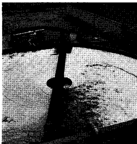
Afb. 5 - Waterstraalbeluchting in zuiveringsinstallatie van textielverwerkende industrie Desso te Dendermonde, België.
