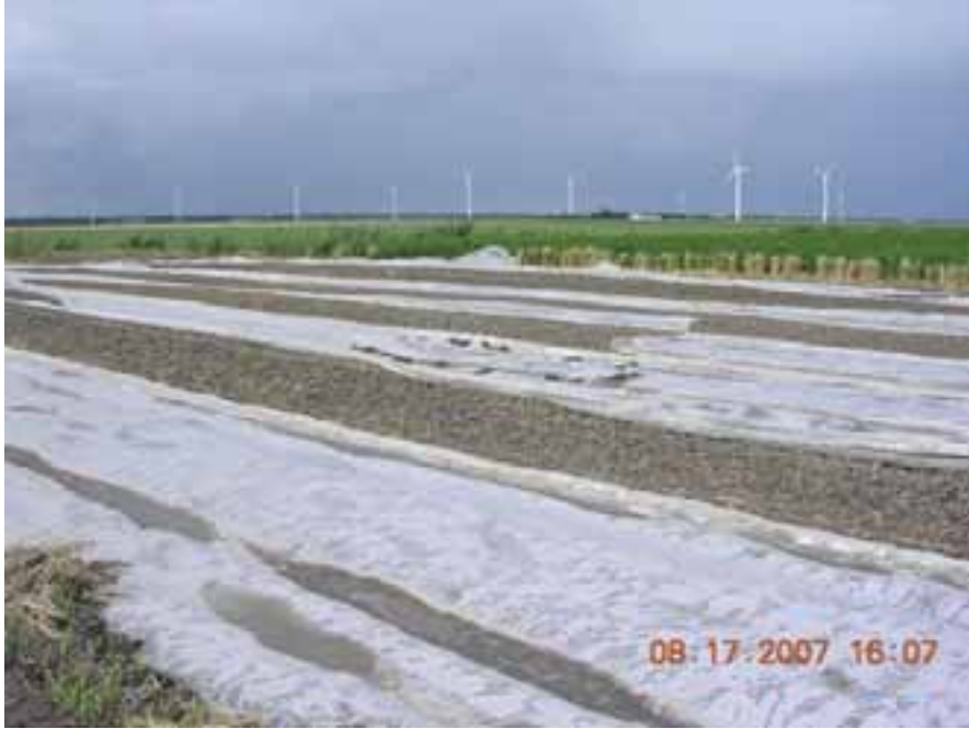
Foto 8. De schade waargenomen op 17 augustus; 25% van het plastic was losgewaaid.
