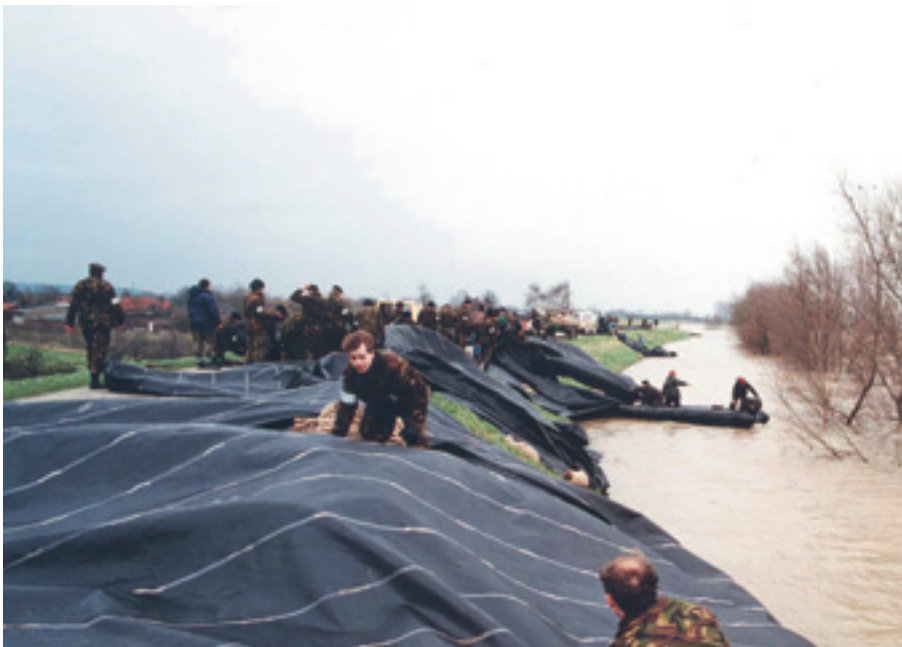
Aanbrengen van verstevigend doek op de dijk van Ochten tijdens het hoogwater op 1 februari 1995.
