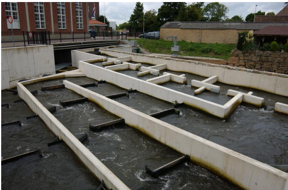
Figuur 3.5. De vertical-slot vispassage bij de ECI-waterkrachtcentrale te Roermond. Foto Rob Gubbels.
