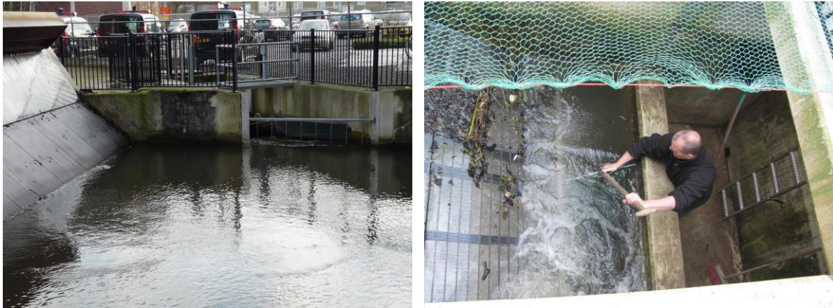
Figuur 4.3. De ingang van de smoltval bevindt zich direct bovenstrooms van het krooshek aan de rechterzijde van de Roer (linkerfoto). Vissen belanden in een betonnen opvangbak en kunnen met behulp van een schepnet gevangen worden (rechterfoto). Foto links Rob Gubbels. Foto rechts Kenneth Gubbels.
