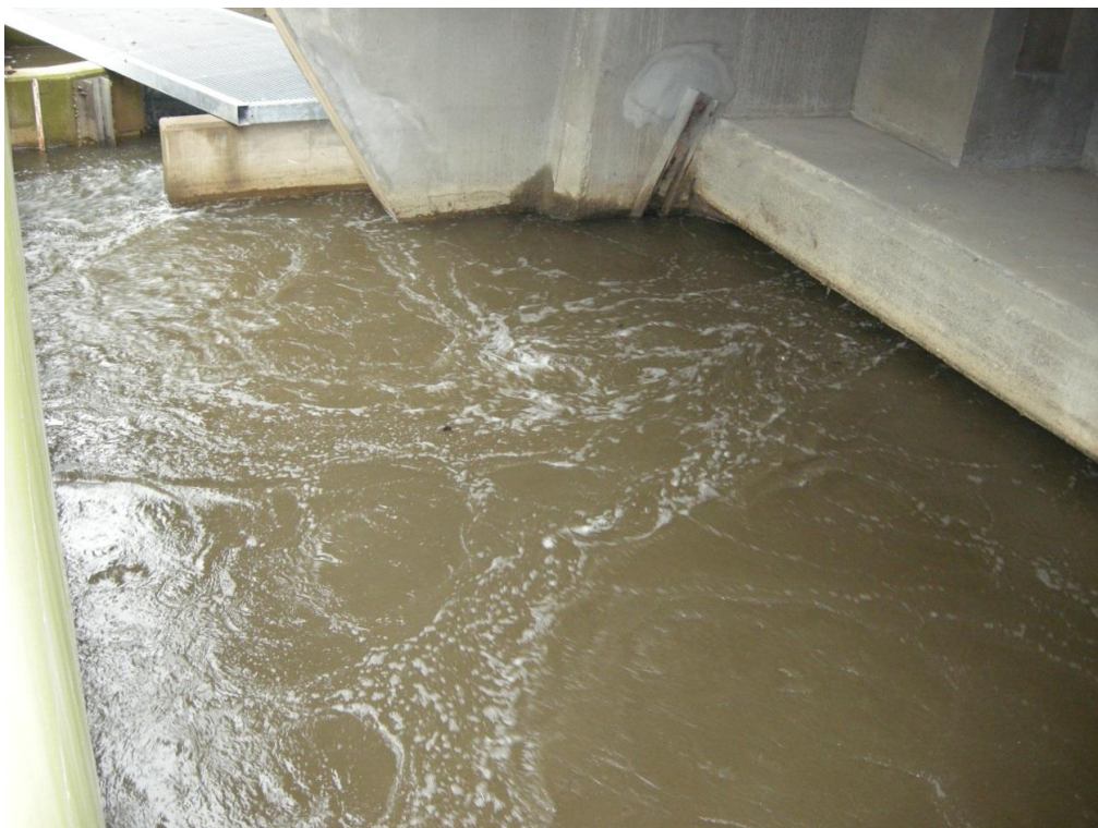
Figuur 3.6. Uitstroom van turbine (midden foto) en uitstroom (lokstroom) van de vispassage (linksboven foto). Foto Buro Floecksmühle.
