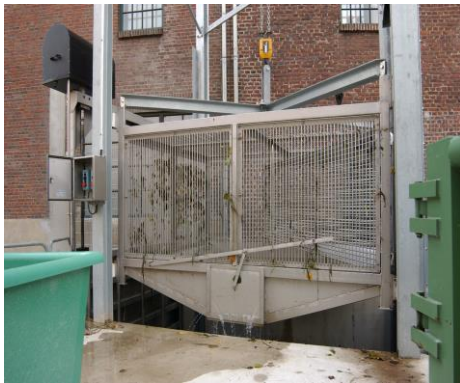
Figuur 4.1. Vangkooi (links) en de keel van de metalen fuik (rechts). Foto's Rob Gubbels.
