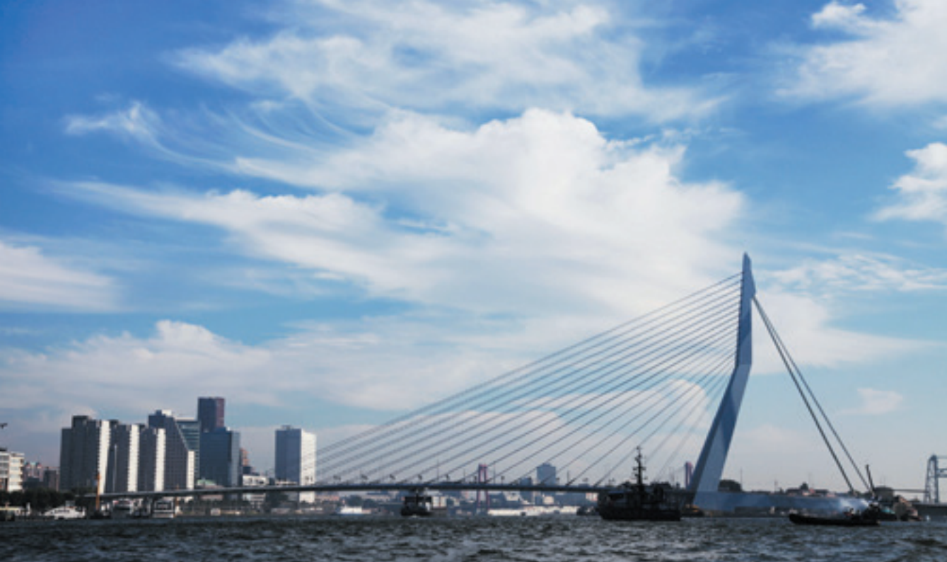
Erasmusbrug: onderdeel architectuurdistrict Rotterdam
