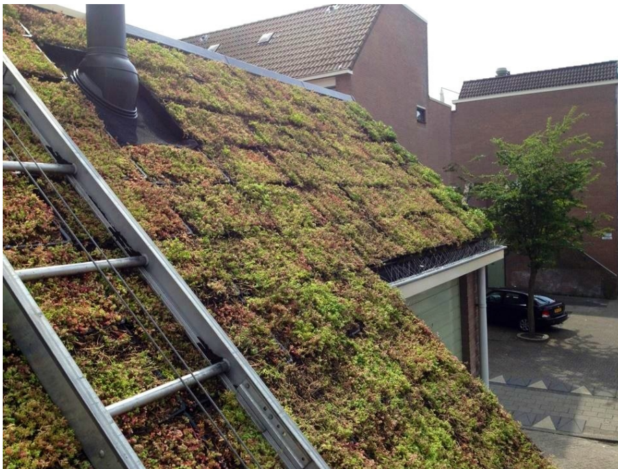
Figuur 3.1 Sociale huurwoningen uitgerust met groene dakpannen in de wijk Transburg in Enschede (foto www.ecopan.nl ).
