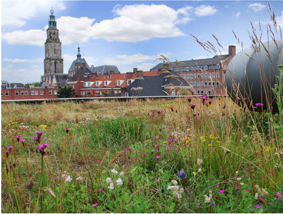
Figuur 3.2 Groendak op het Werkmancollege, Groningen (Foto www.optigroen.nl ).
