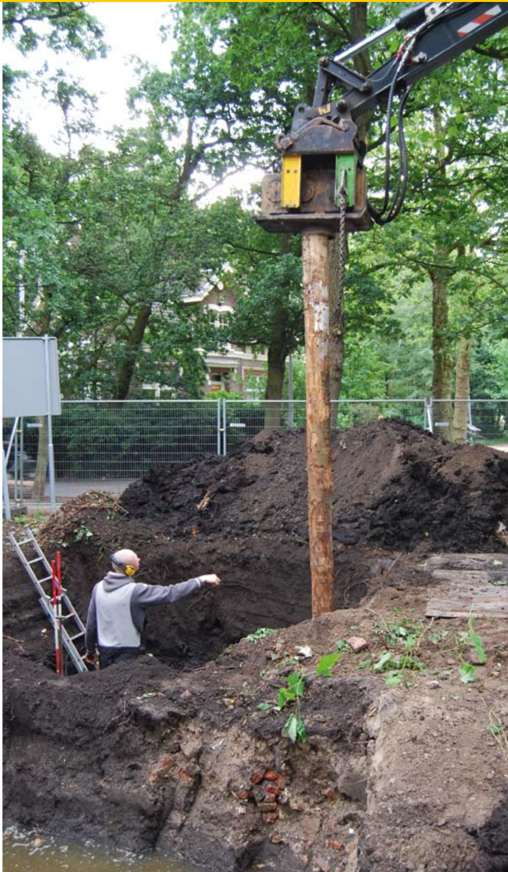
De palen worden de grond in gedrukt.
