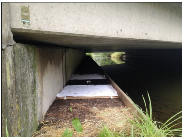
Figuur 4.5 Sporenbed op een looprighel onder de brug over de Bielheimerbeek.
