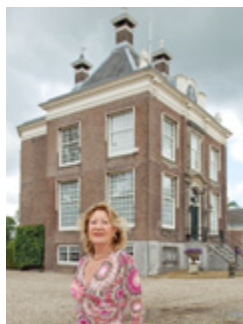
Ilona Oberman bewoont de buitenplaats Oostermeer aan de Amstel, uit 1728
