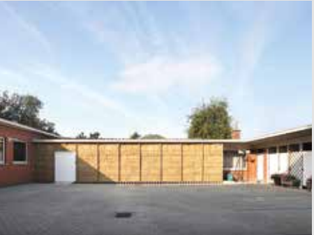
België, aanbouw met stro – Refuge II – Evere – Goes architecten (STRO)
