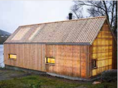
Verbouwing boothuis in Noorwegen (HOUT)
