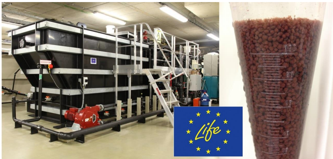
Afbeelding 3. De CENIRELTA-demonstratie-installatie op RWZI Dokhaven(I) en anammox-korrelslib(r)
