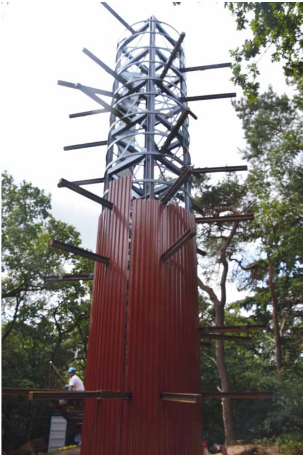
Aanleg uitkijktoren Bosberg.
