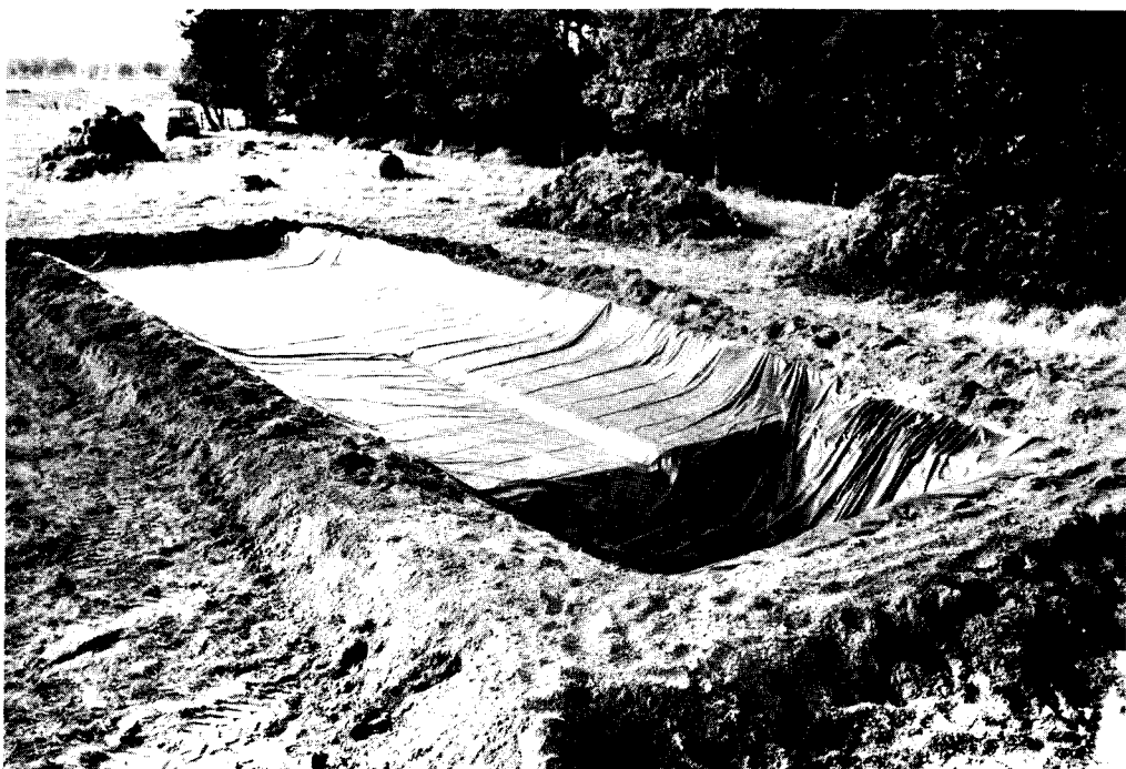
Afb. 1 - Sleufkuil en afvoerput voorzien van een grondzeil.
