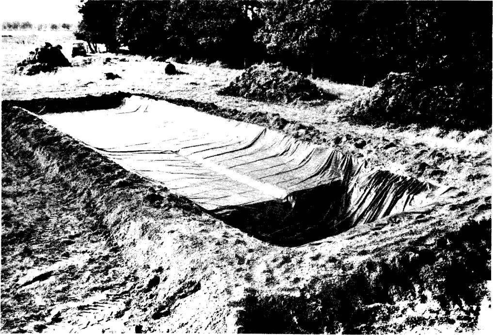
Afb. 1 - Sleufkuil en afvoerput voorzien van een grondzeil.
