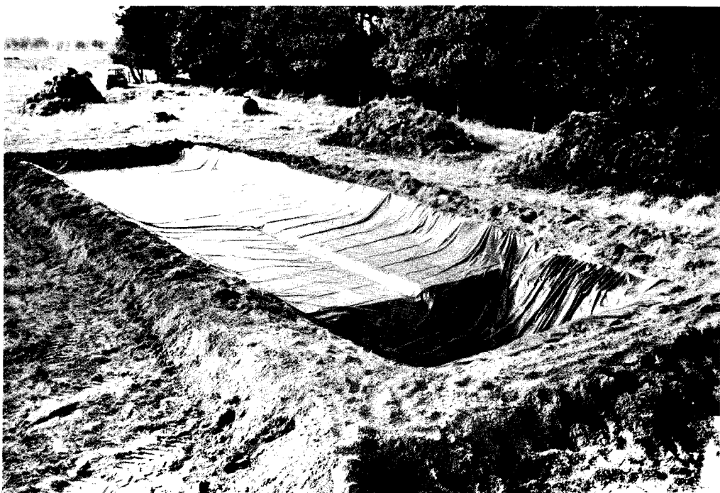
Afb. 1 - Sleufkuil en afvoerput voorzien van een grondzeil.
