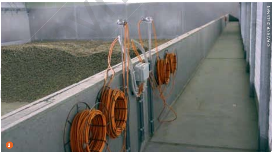
1 Tussen de bestaande stallen en de nieuwe loods werd een overkapping gebouwd, die toelaat droog te werken. Ze wordt ook gebruikt voor de aanvoer naar de mestverwerkingsinstallatie. 2 Een gaanderij bovenop de drukgang laat toe om de bewaring gemakkelijk op te volgen.
