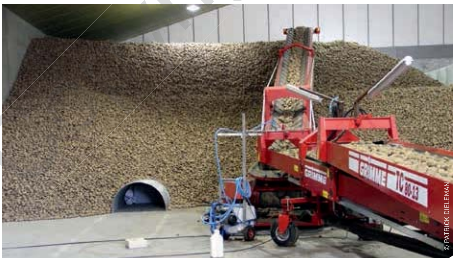
Bovengrondse kanalen zijn goedkoper dan een roostervloer, maar bij het in- en uitschuren moeten ze worden opgezet en weggenomen met kans op beschadiging. Een voordeel is dat men de loods ook voor andere doeleinden kan gebruiken, zoals het tijdelijk stockeren van graan.
