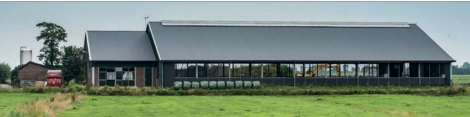
Het dak van de nieuwe stal wordt nog dit jaar voorzien van 600 vierkante meter zonnepanelen
