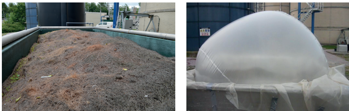
FIGUUR 1.1 LINKS: GEURFILTER MET KOKOS EN LAVA, RECHTS ALTERNATIEF EXTERNE KELDERBALLON (RWZI ZAANDAM)
