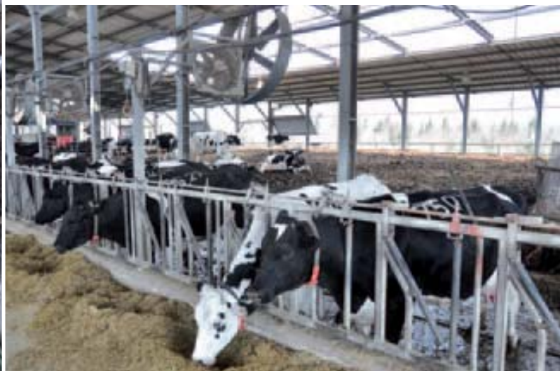
De kleine ventilatoren zijn iets gekanteld, waardoor ze de lucht over en tegen de koeien blazen die aan het voerhek staan te eten.
