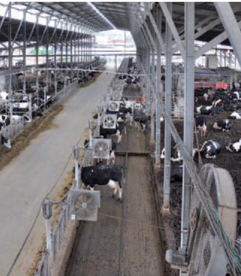
Vertikaal draaiende ventilatoren trekken de lucht in de lengte door deze Israëlische stal. De ventilator rechtsvoor zorgt voor een luchtbeving overdwars.
