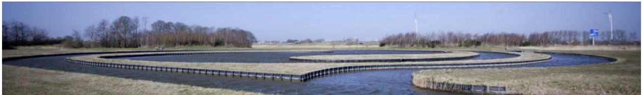
Foto 7. Bezinksloten van de defosfatering in het park van Luna
