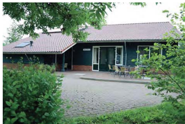
Gastenverblijf Betlehem biedt ruimte aan 15 mensen en heeft gedurende het hele jaar een kamerbezetting van 90 procent. Sinds 2013 werkt Vonk met zonnepanelen en een warmtesysteem (op Betlehem), waardoor het bedrijf zelfvoorzienend is wat betreft stroom.
