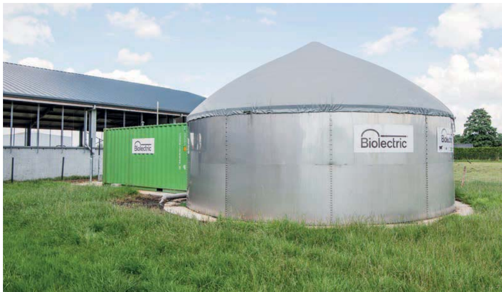
Dagelijks gaat vijf kuub mest in de pocketvergister voor productie van elektriciteit
