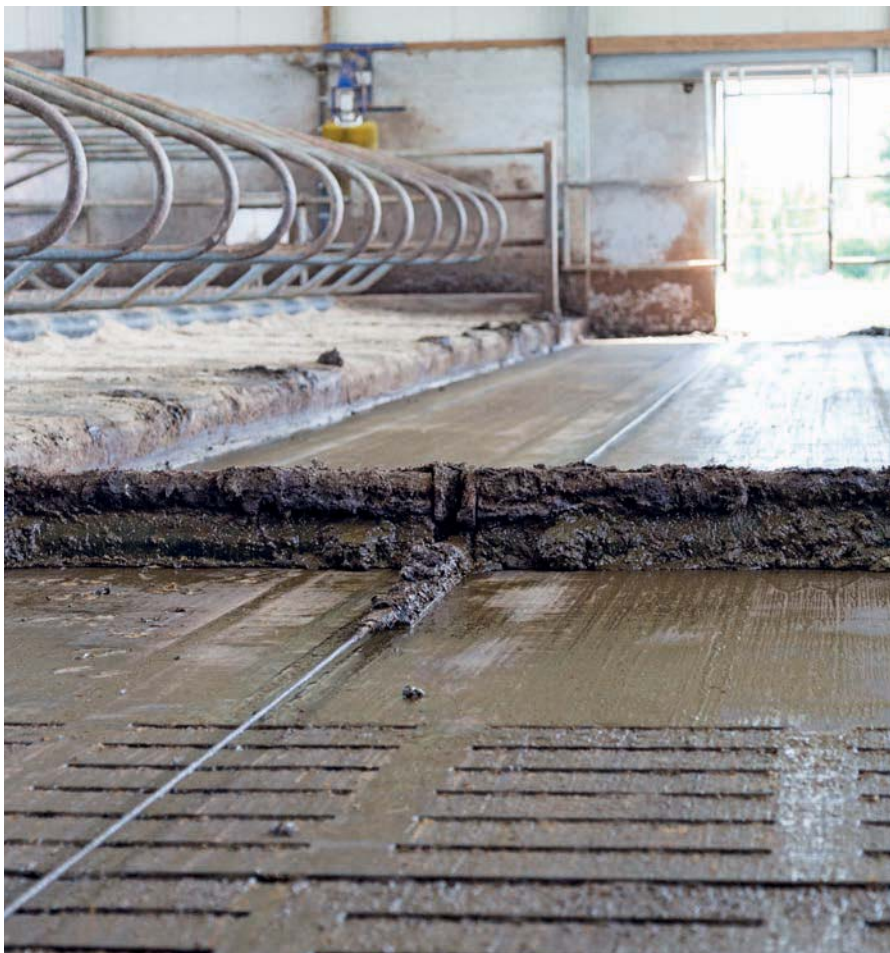
Tussen de ligboxen ligt een dichte vloer met mestschuif
