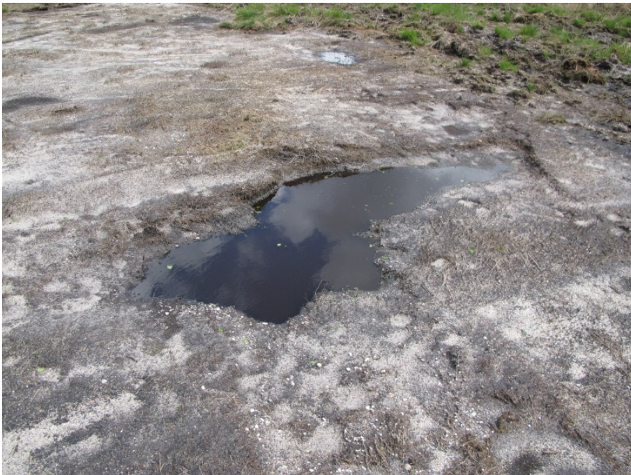
Afb. 7.1. Onregelmatig microreliëf met verslechte en daardoor water stagnerende kuilen (o.a. plagplek 15).
