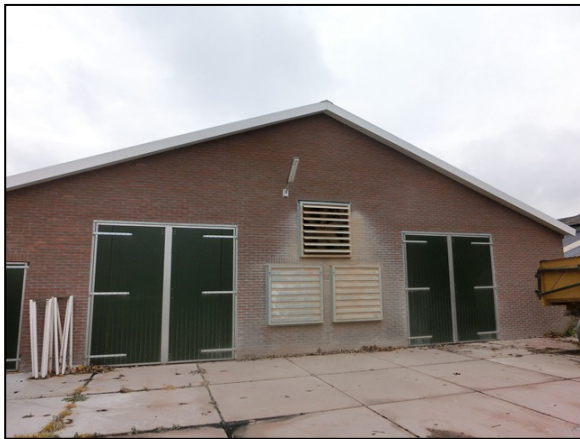
Achtergevel met drie ventilatoren
