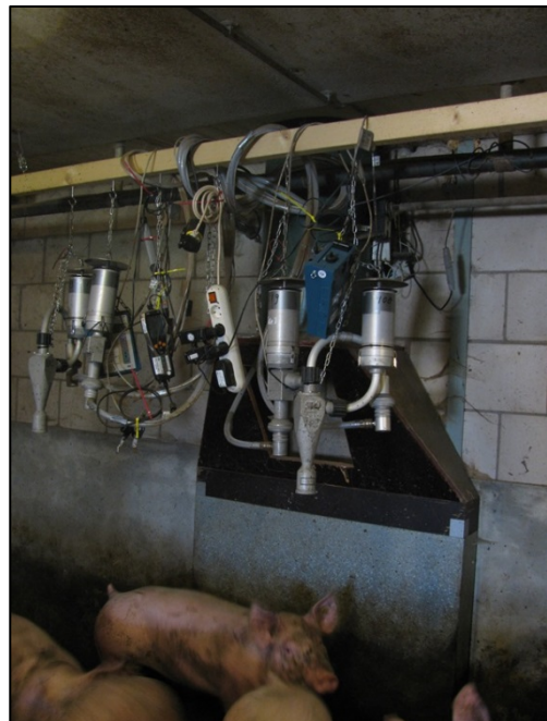
Vleesvarkenstal 2 – Monsternamen in de afdeling, nabij de koker naar het luchtafvoerkanaal
