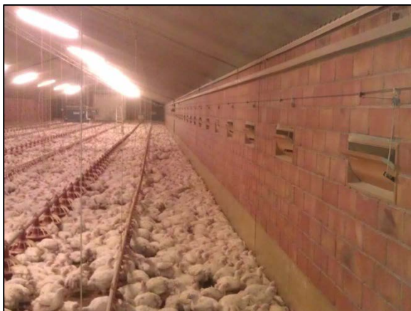
Binnenaanzicht van de stal met inlaatventielen in de zijgevel
