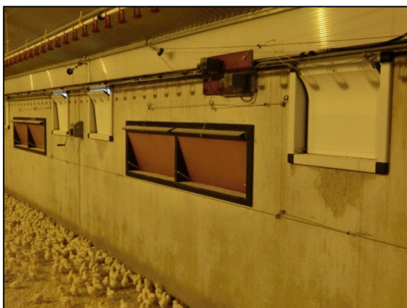
Detailfoto van de inlaatventielen in de zijgevel: witte standaard ventielen en oranjebruine zomerventielen voor extra inlaat
