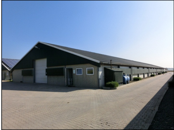
Voorgevel en rechter zijgevel met inlaatventielen achter de winddrukkappen
