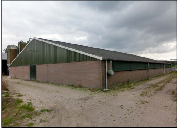
Voorgevel en rechter zijgevel van de stal. De luchtinlaat bevindt zich achter het groene doek in de zijgevel
