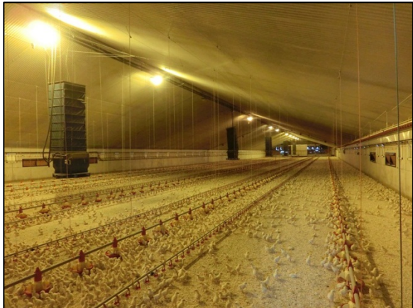
Overzichtsfoto van de stal met hogedruknatriumlampen in de nok, warmteheaters en voer- en drinklijnen
