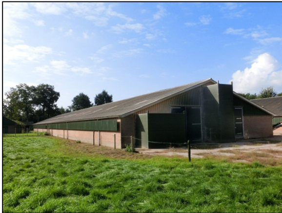
Achtergevel met twee 'stofbakken' op de plaatsen waar ventilatoren in de gevel zitten
