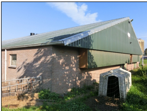
Voorgevel met luchtinlaat via de langwerpige 'bak' met geperforeerde groene damwandplaat
