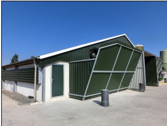
Achtergevel met (v.l.n.r.): een toegangsdeur, een (schuin oplopende) stofbak met één zichtbare ventilator, doorgang naar de roldeur, en een tweede stofbak met ventilatoren
