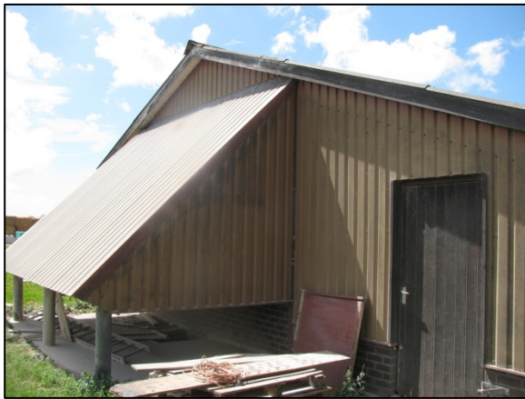
Achtergevel met lichtkap en een toegangsdeur
