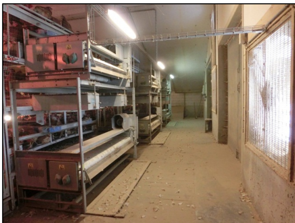
Ruimte tussen het einde van de systeemrijen en de achtergevel
