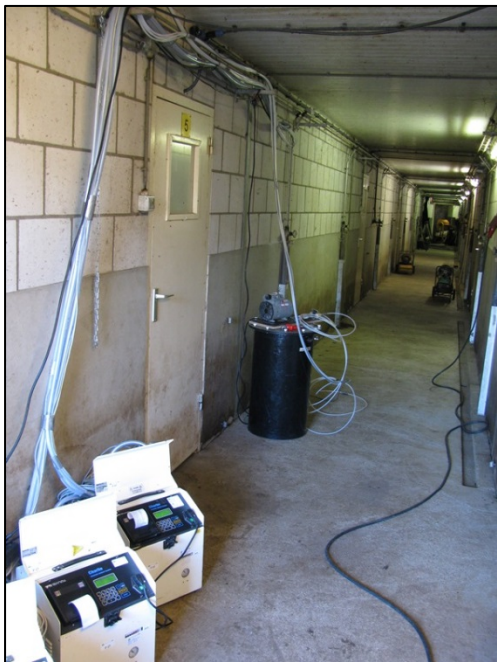
Vleesvarkenstal 2 – Opstelling apparatuur in de centrale gang en leidingenbundel naar de afdeling
