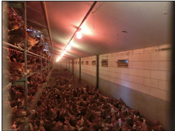
Zijgevel met inlaatventielen, plafond met PL-lampen, strooiselvloer en voliërestelling
