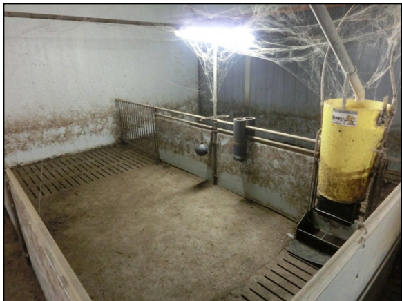
Detailfoto van één van de hokken, met (van voor naar achter): een waterkanaal met betonroosters, een bolle vloer en een mestkanaal met betonroosters. Aan de rechter hokafscheiding zijn zichtbaar: een speelbal, een strokoker en een droogvoerbak met drinknippel
