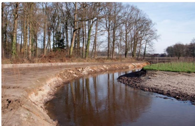
Door stuwen te verwijderen en hermeandering wordt de beek in oude luister hersteld.
