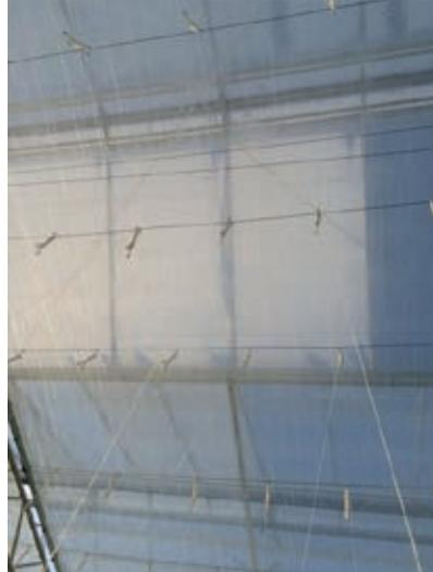
**Abbildung 1.9** Teilweise geschlossene Schneedecke am 27. Dezember 2014 (A) und eisfreie Ränder um Rinne, Strebe und Riegel (B).
