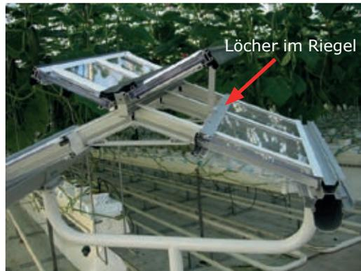
**Abbildung 1.8** Ansaugung der Gewächshausluft mit Einblasen in die Rinne (A) und Entlüftungsöffnungen bei geöffneter Lüftungsöffnung (B).
