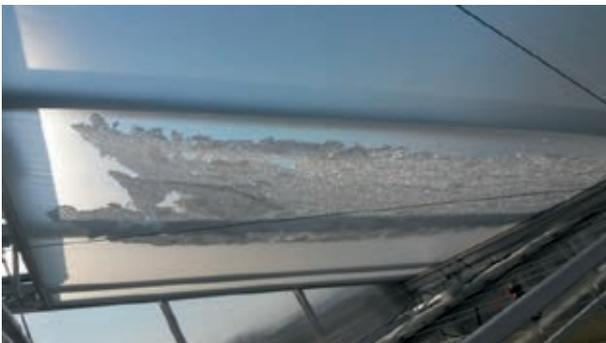
**Abbildung 1.11** Zerbrochene Scheibe wird von der Folie aufgefangen.
