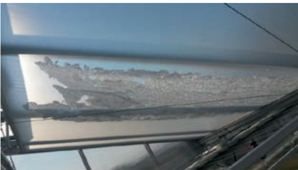
Figuur 1.11 Gebroken ruit wordt door de film opgevangen.
