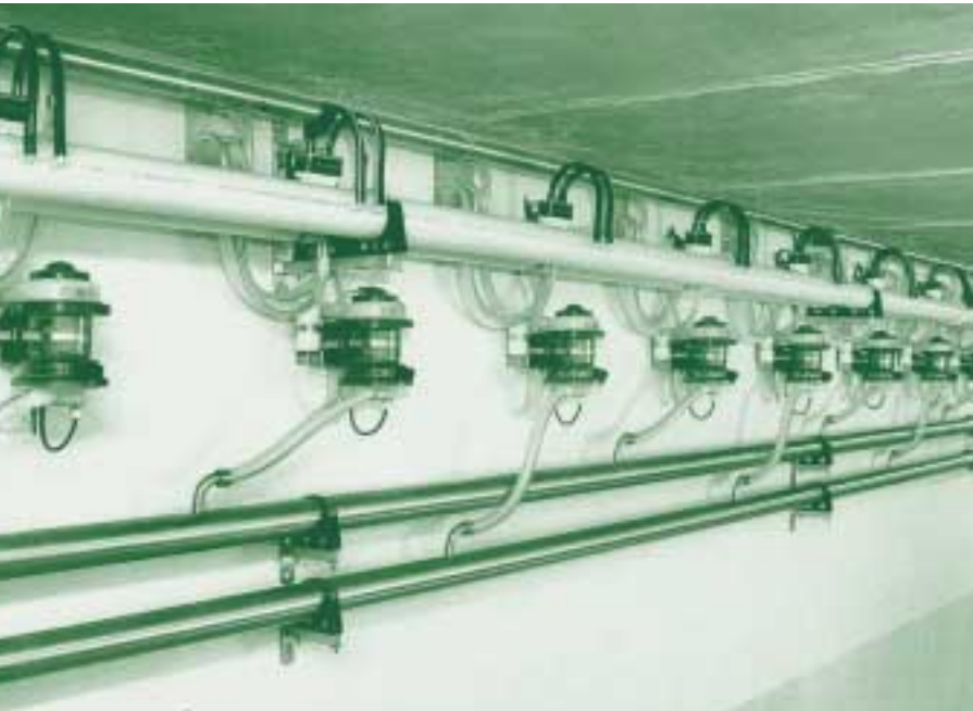
Apparatuur kan ook onder de standen in een kelder worden weggewerkt.
