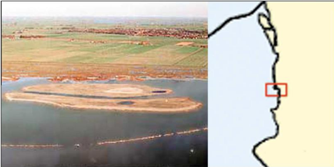
Figuur 2.7 Eilandjes bij It Soal achter de stortstenen dam.
