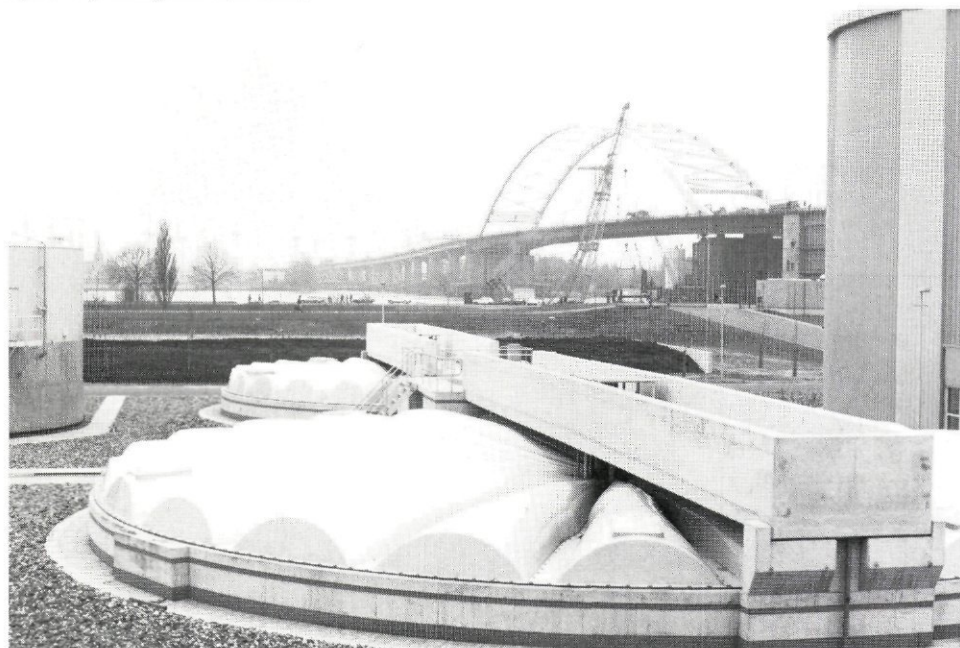
Afb. 3 - Afdekking voorbezinktanks.
