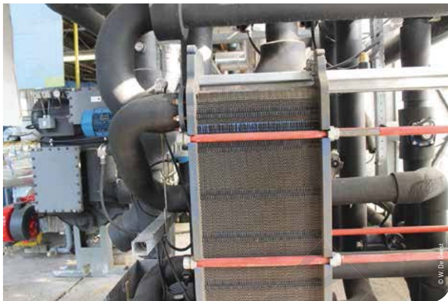
▲ Voor een gasabsorptiewarmtepomp is een milieuvergunning klasse I vereist omwille van de koude- en warmteopslag in de bodem
