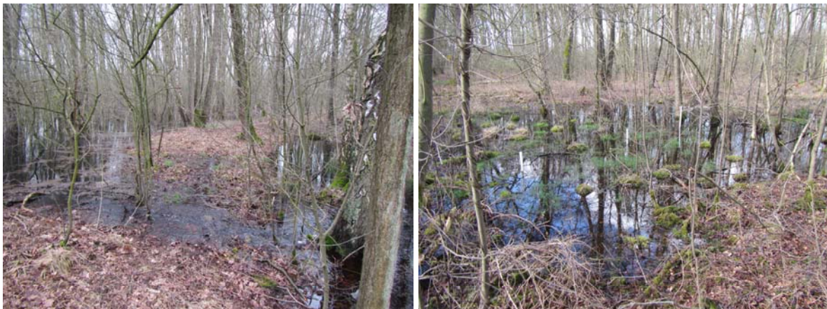
Figuur 5.7. Links: de wal (waarop het toegangspad ligt) in de slenk tussen peilbuisraai B-B' en referentielocaties R3-R6 functioneert als een dam en blokkeert de waterafvoer/doorstroming waardoor regenwaterlenzen ontstaan. In natte periodes (o.a. 31 maart 2015) stroomt er oppervlaktewater in noordoostelijke richting over het pad. Rechts: foto van Bo26 bij Tpb10. Foto's: Mark van Mullekom.
