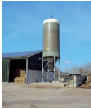
De nieuwe silo op het erf van Breij bevat tarwegistconcentraat.
