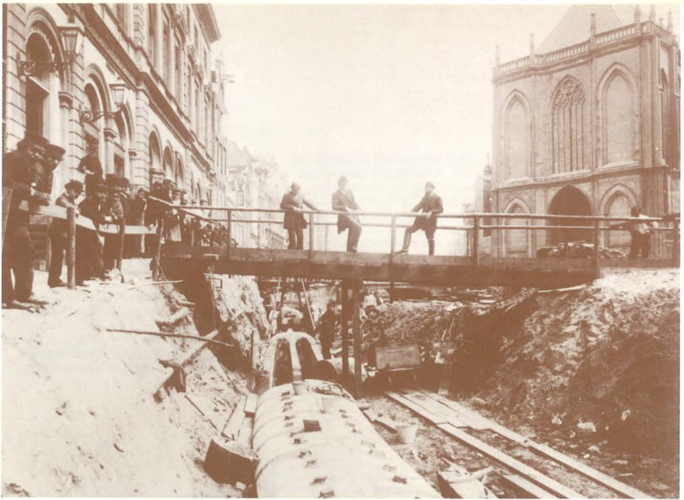
Het leggen van een hoofdriool op de N.Z. Voorburgwal ter hoogte van het postkantoor
