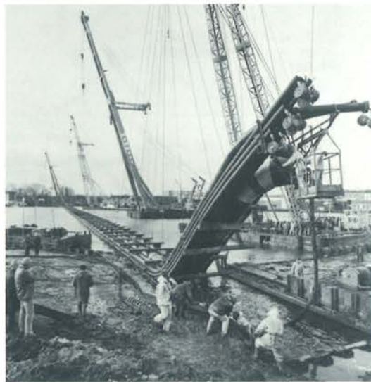
Vier drijvende bokken nemen de 380 ton zware zinkers in de takels. Dit gebeurde op 28 november 1980
