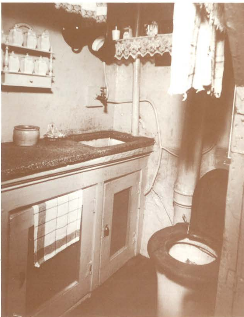
Kromboomsloot no. 10 in juni 1934. Een open WC in de keuken
