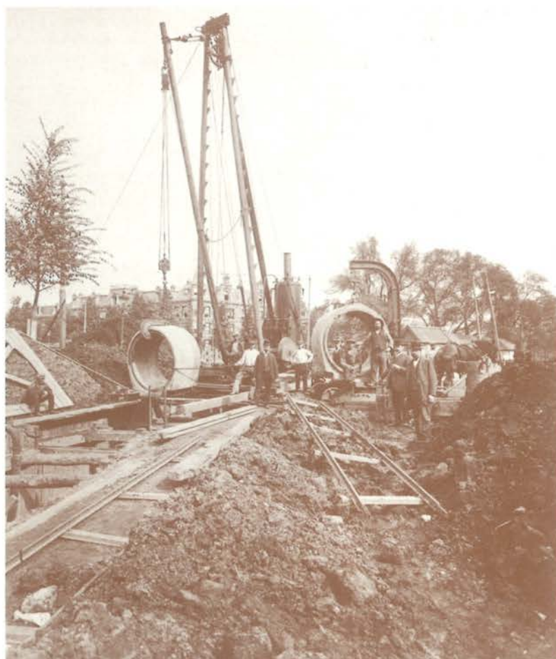
Het leggen van een zinker in de Amstel, hoek Stadhouderskade
