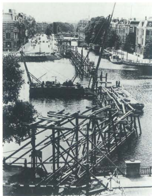
Het leggen van een zinker in de Amstel, hoek Stadhouderskade
