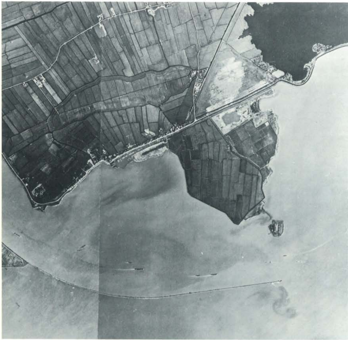
Het eiland Zeeburg en de 6500 meter lange persleiding in 1978. Op de foto is de R.I.-Oost ingemonteerd. De 'vevlek' is duidelijk te zien
