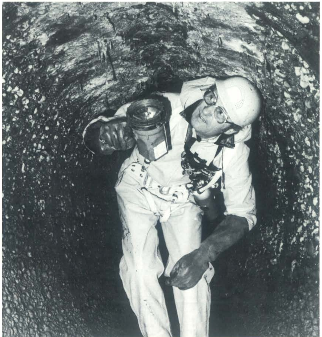
Inwendige inspectie van een riool
