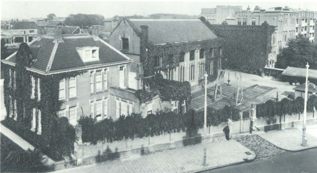
Het gemaal aan de Zeeburgerdijk
