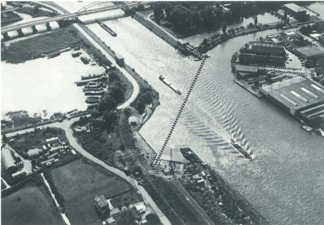
De ligging van de nieuwe zinker in de bodem van het Amsterdam-Rijnkanaal
