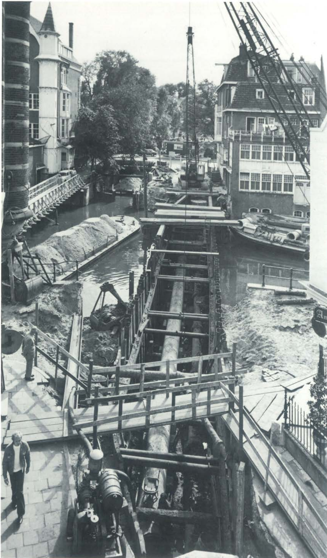
Aanleg van een zinker in een bouwput door de Lijnbaansgracht
