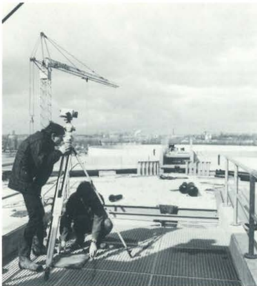
Van boven naar beneden: Landmeters aan het werk op het dak van één van de gistingtanks
