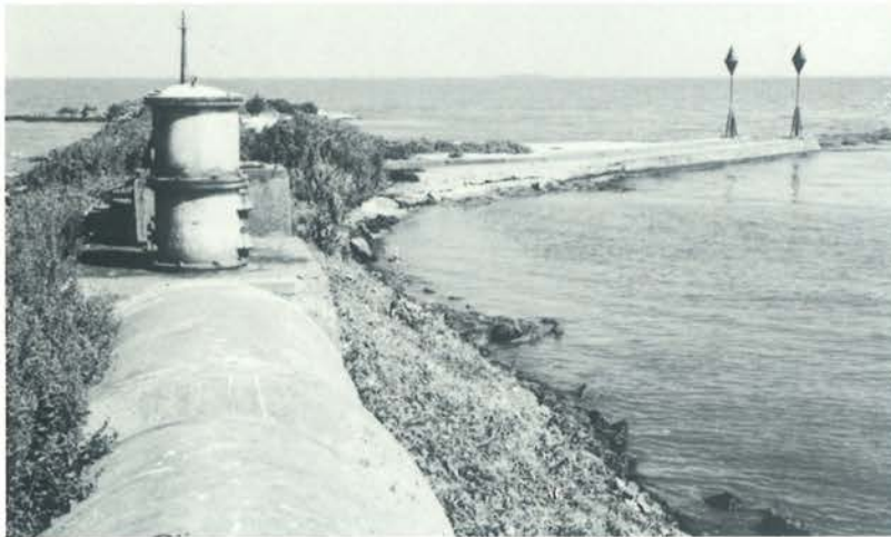
Het einde van de persleiding. Letterlijk en figuurlijk, want op 19 januari 1982 werd overgeschakeld op de nieuwe installatie op Zeeburg. De vetvlek, jarenlang een baken in zee, is verdwenen
