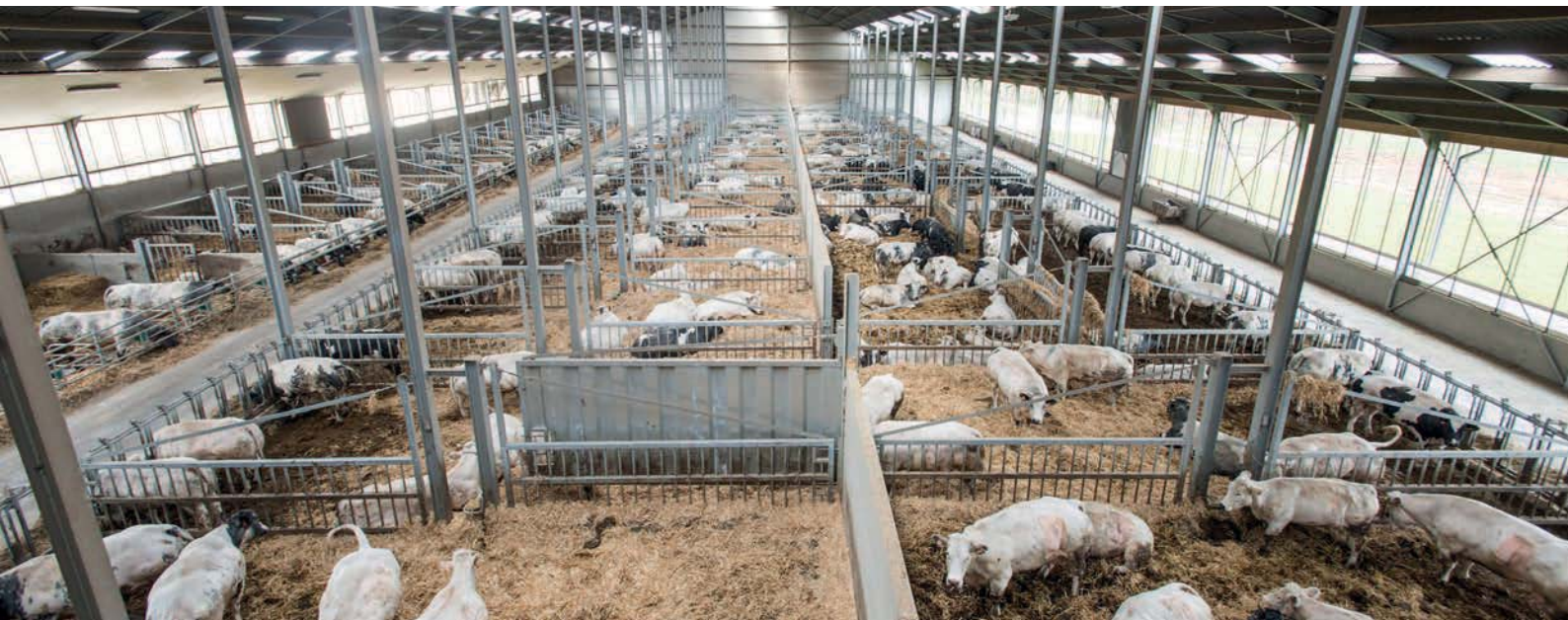
De nieuwe vleesveestal is 97 meter lang bij 40 meter breed
