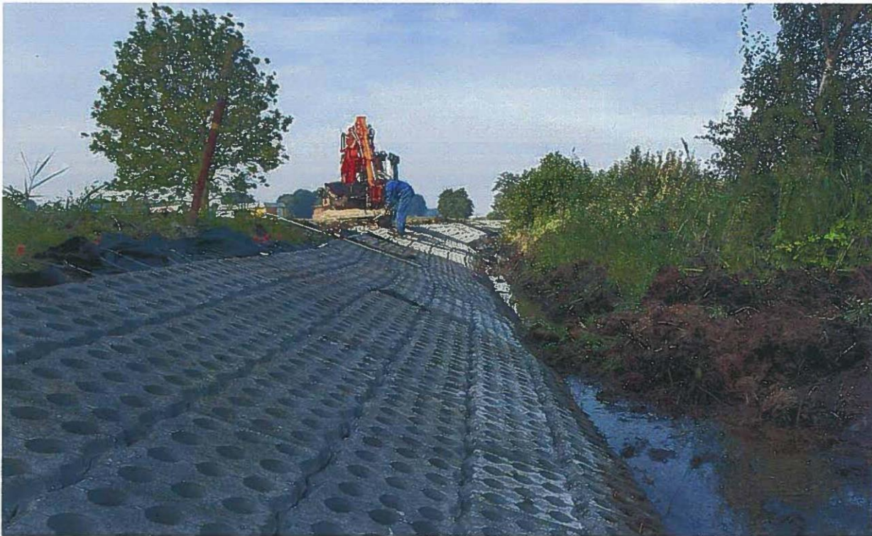
Foto 3: Uitvoering van proefvak 1- betonnenmatten, bron Hoogheemraadschap van Rijnland.
