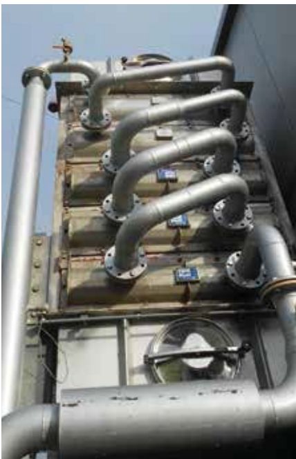
Evers heeft zelf een RVS-condensor gebouwd die het rendement van de houtstook flink verhoogt.
