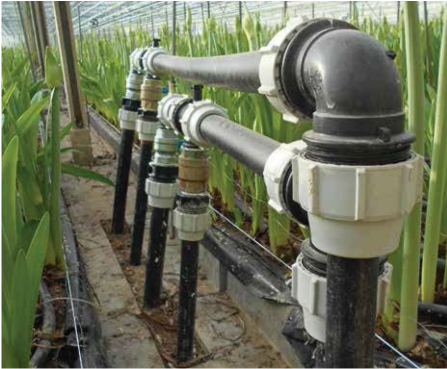
De warmte van de condensor gaat via het lagetemperatuur netwerk naar de PE-slangen onder de amaryllisbedden.
