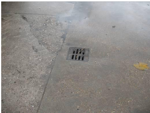
Foto 1 Afvoerput op het verharde erf
