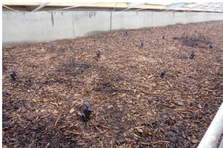
Figuur 24: Het biobed met de natte houtsnippers tussen de stal en de kas voor filtering van de ammoniak uit de stallucht.
