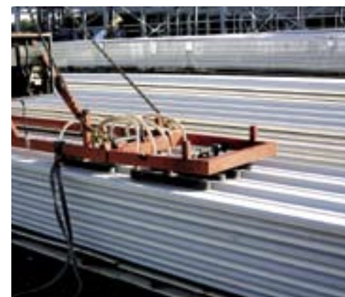
De dak- en wandbeplating wordt met een zuignap op het dak gezet.
