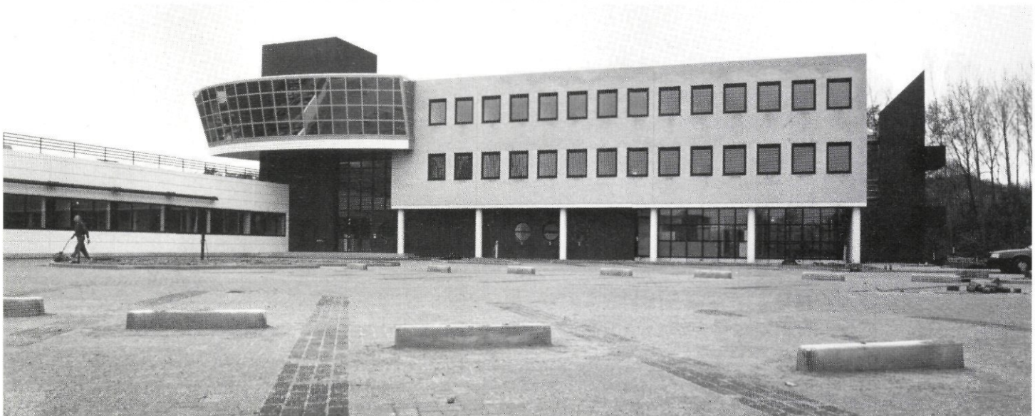
Afb. 1 - Het nieuwe gebouw op de vestiging Leiduin met in de laagbouw het moderne laboratorium en in de hoogbouw de kantooreluegels voor drie afdelingen.
