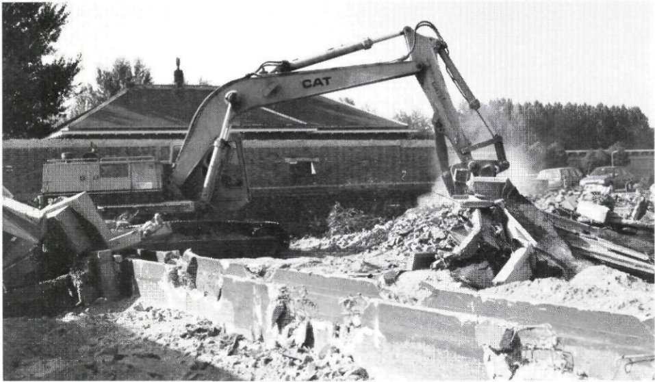
Afb. 5 - Om ruimte te scheppen voor het ozonisatie- en koolfiltratiegebouw worden verschillende oude gebouwen gesloopt, waaronder een zeventig jaar oud langzaam zandfilter.
