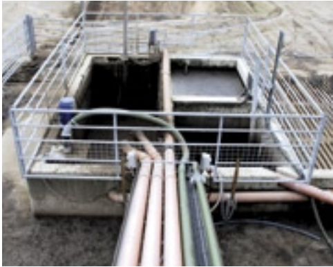
De bezinkputten van de zandwasser. Helemaal rechts de afstortput voor de mest.
